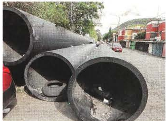
■ Algunos tubos que se colocarían para desalojar agua pluvial permanecen en las calles de Ejército de Oriente.
