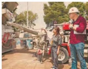
La jefa de Gobierno encabezó la supervisión de los trabajos hidráulicos orientados a prevenir inundaciones en la alcaldía Venustiano Carranza
