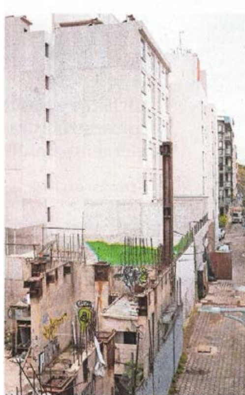
En la calle Emiliano Zapata 56, de la Portales Sur, se observó un edificio concluido.
