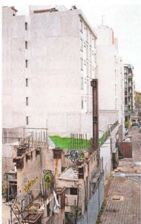
En la calle Emiliano Zapata 56, de la Portales Sur, se observó un edificio concluido.
