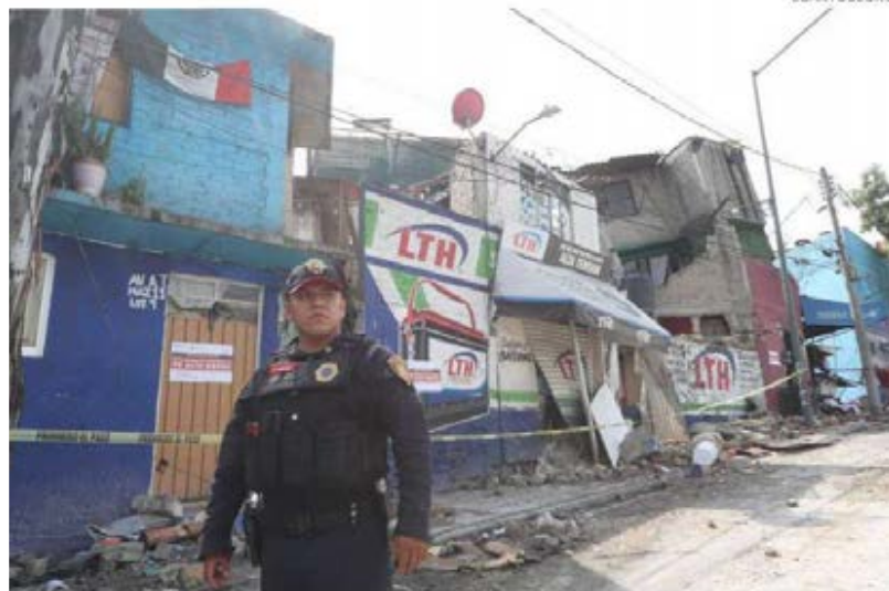
La explosión en un puesto de tacos en la colonia Minas de Cristo ocasionó la muerte de dos personas, 25 lesionados y daños materiales en cinco predios.
