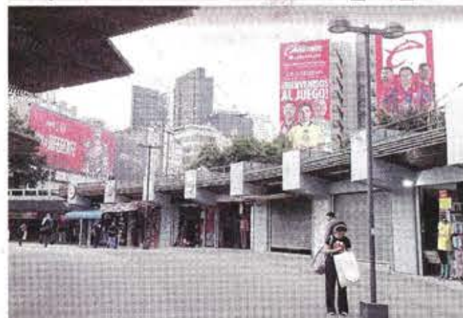
Lonas publicitarias se encuentran colgadas sobre muros de edificios, lo cual está prohibido por la normatividad.
