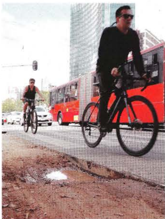
Pedelistas deben esquivar las zanjas abiertas en su carril.
