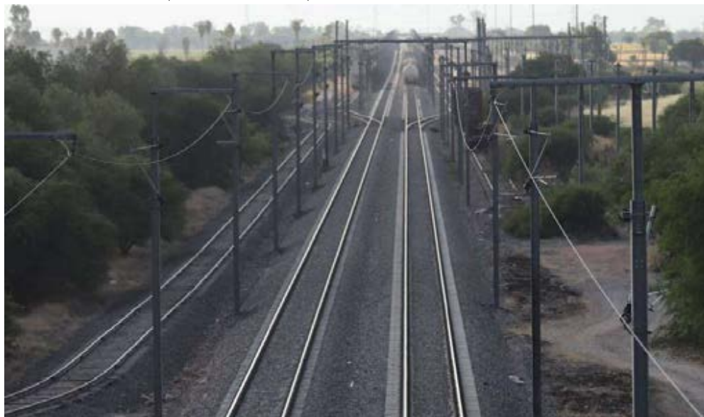
Obras del Tren CDMX Querétaro.
