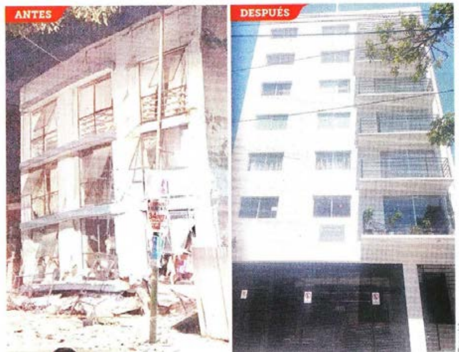
El edificio ubicado en Saratoga 714, en la Colonia Portales Sur, Alcaldía BJ, fue reconstruido.
