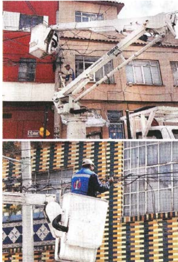
Personal de las alcaldías, así como de empresas de telefonía y telecomunicaciones, realizan el retiro de cableado.
