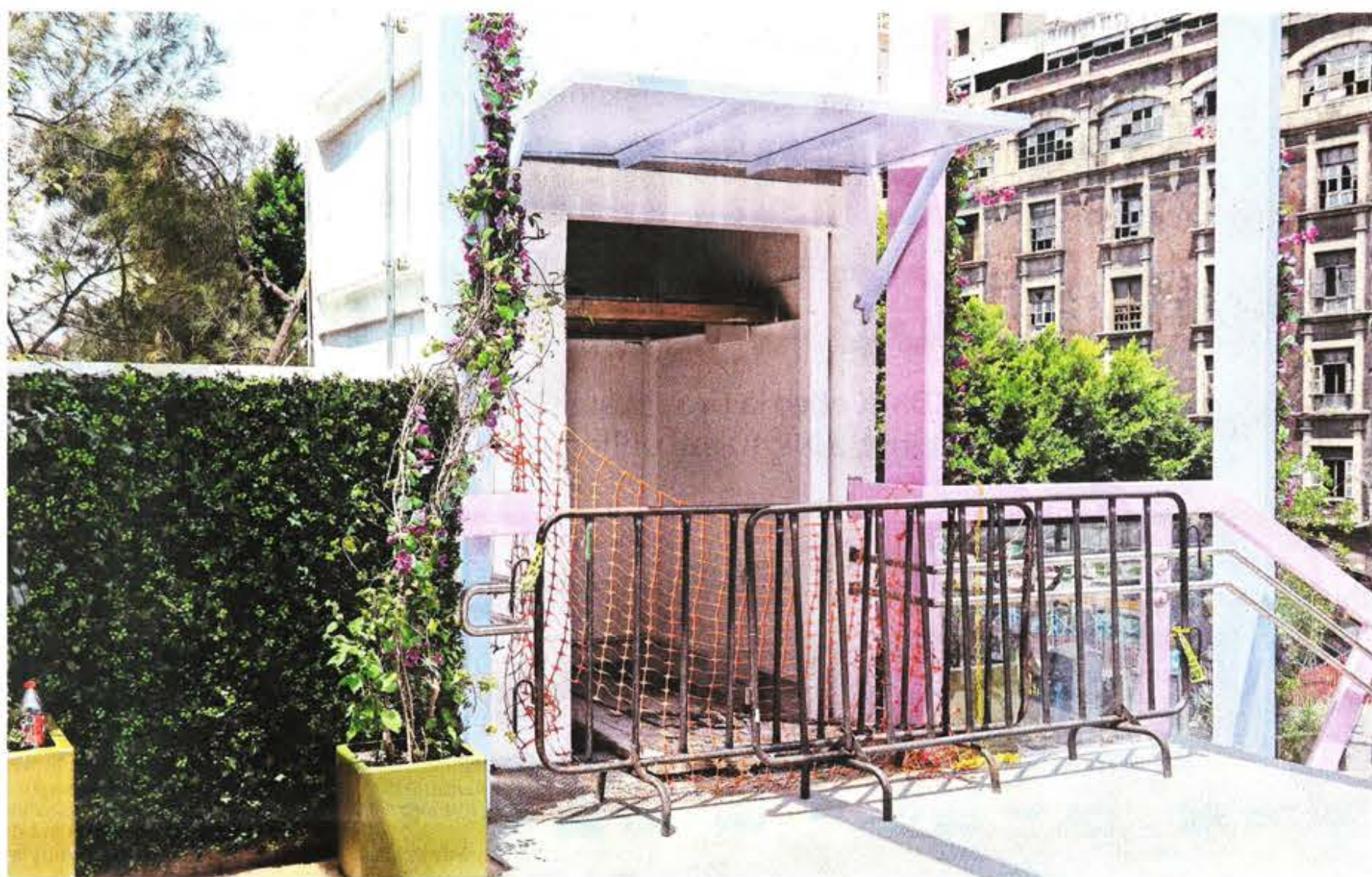
Durante un recorrido por el Jardín Flotante se observó que algunos elevadores están inhabilitados y sin acceso para las personas.
