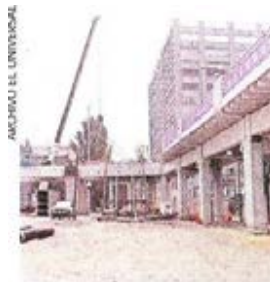
El skatepark de San Antonio Abad fue demolido en mayo.
