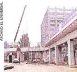
El skatepark de San Antonio Abad fue demolido en mayo.
