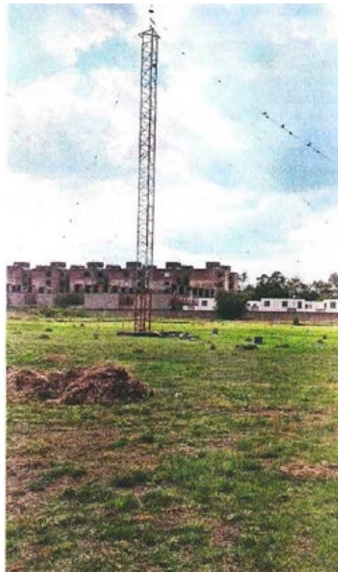
Su planta de transmisiones en Ejército de Oriente tiene problemas severos que requieren mantenimiento.
