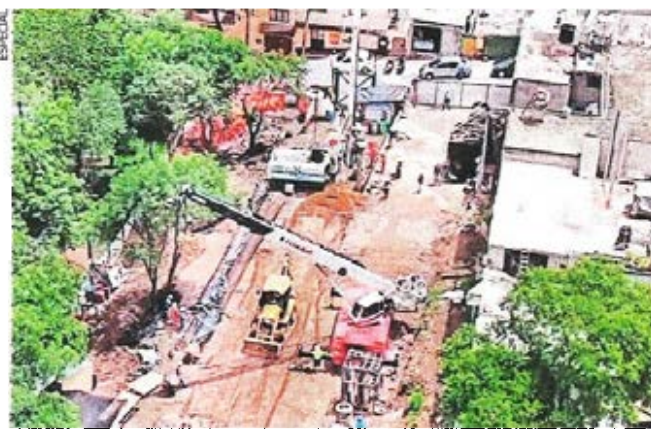
La Secretaría de Obras y Servicios ha reportado los avances de la cimentación para los postes de la Línea 5 del Cablebús en Á. Obregón.
