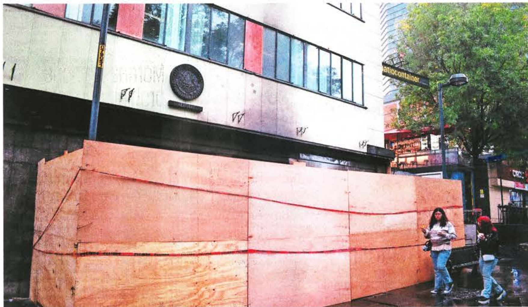
En el inmueble ubicado sobre avenida Juárez se colocaron tabloncillos de madera y se acordonó la zona.
