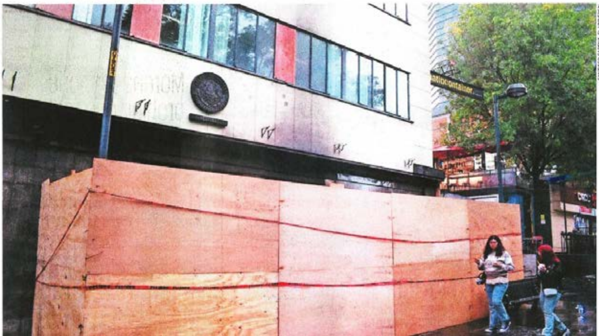
En el inmueble ubicado sobre avenida Juárez se colocaron tablonés de madera y se acordonó la zona.
