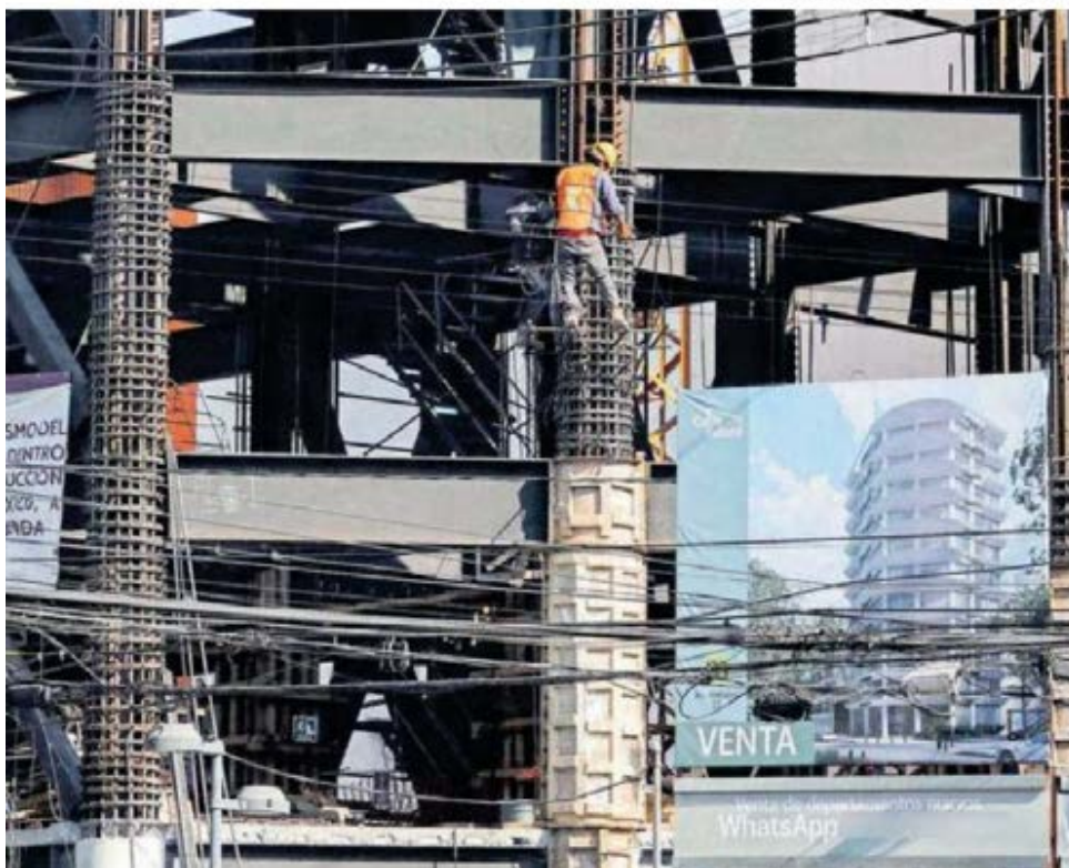
Un edificio de departamentos en proceso de construcción, en la alcaldía Cuauhtémoc
