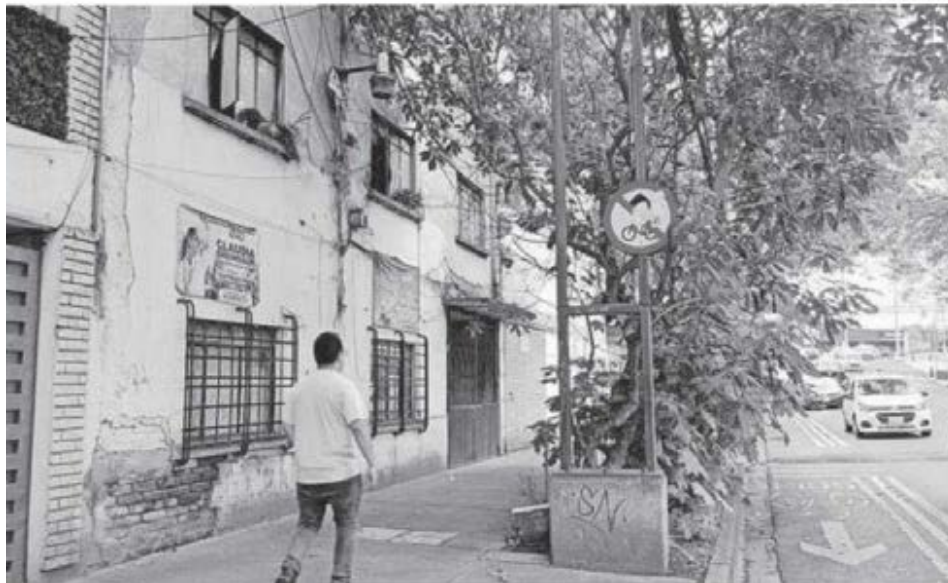
Predio ubicado en Monterrey 376 que será expropiado por el alto riesgo para quienes lo habitan
