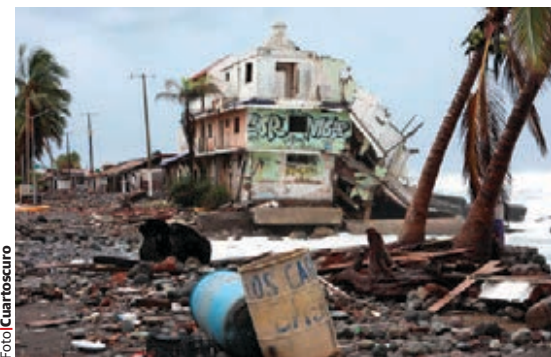
ARMERÍA, Colima, ayer, afectado por lluvias.
