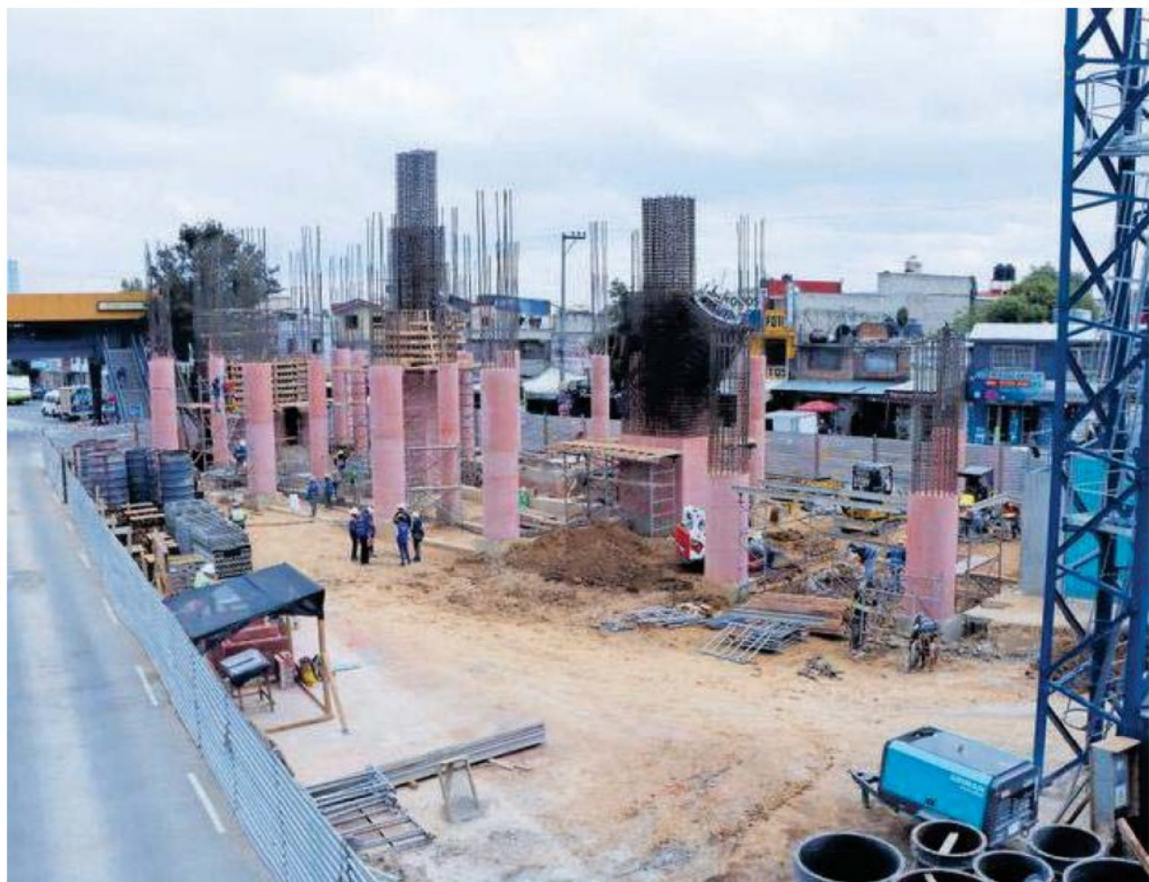
Avanzan las obras del Cablebús Línea 4 en el Metro Universidad
